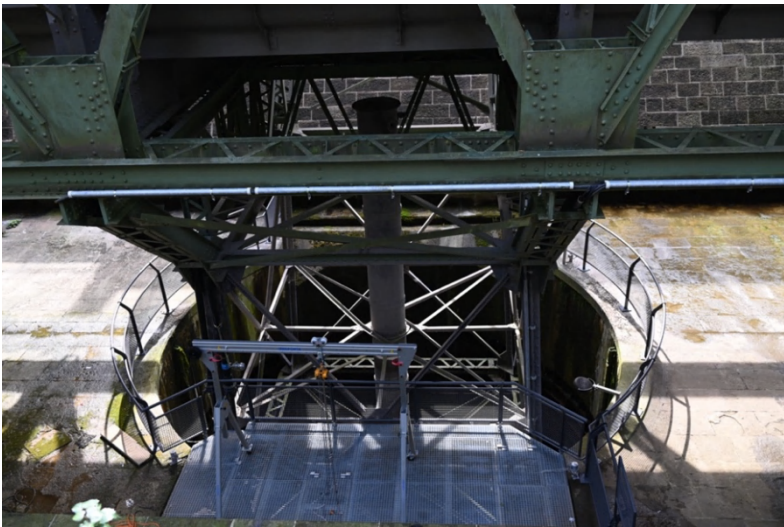
Abbildung 3: Blick in einen der fünf Schwimmerschächte (Foto: W. Steiling, 2025)
