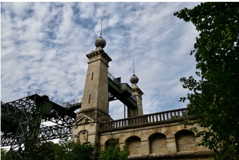
Abbildung 2: Türme des Schiffshebewerkes Henrichenburg (Foto: W. Steiling, 2025)
