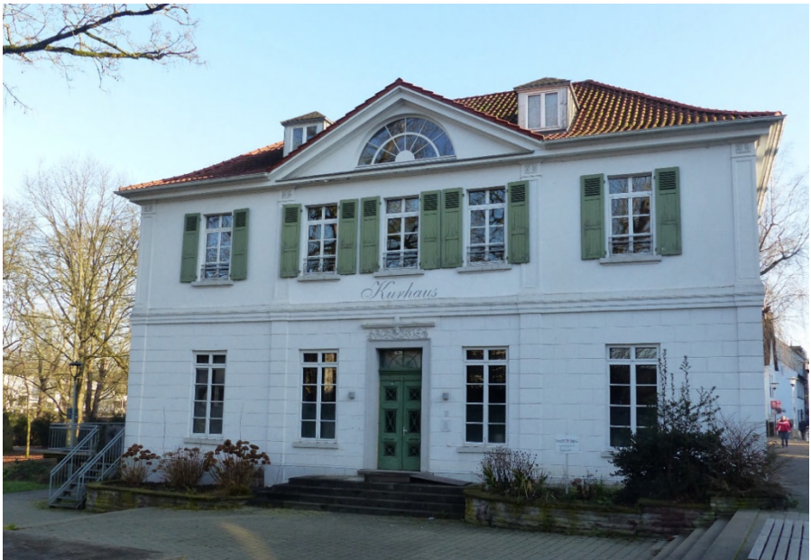
Abbildung 9: Das sogenannte Kurhaus, Bahnstraße 18, erbaut um 1840 (Foto: H. Osmann, 2025)
